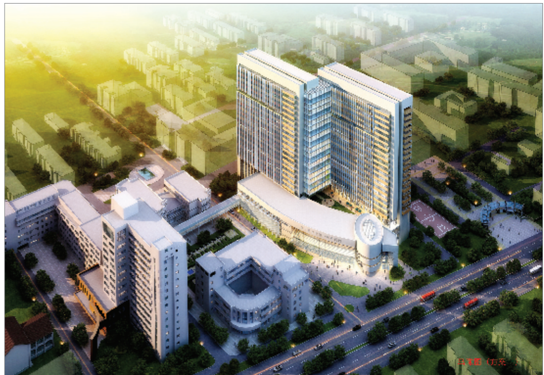
正在建设中的23层5A级智能化药房大楼
